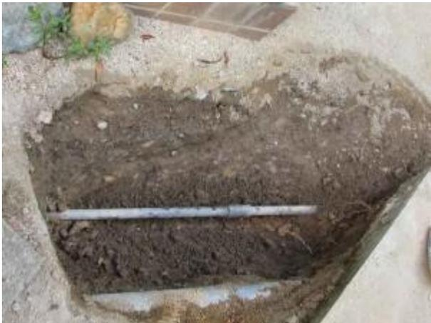
手前の管が排水管、奥の細いのが水道管です、元栓を閉めずに穴を掘ったので土の水分量が増えていくのでこの辺りだと言うことはすぐに分かりました。
