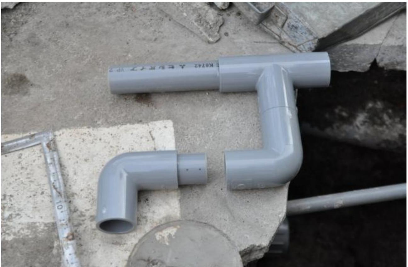
図面通り部材を加工して接着の順番を検討する、接着剤を塗布すると直ぐ硬化するので順番を間違えるとヤバイことになる。
