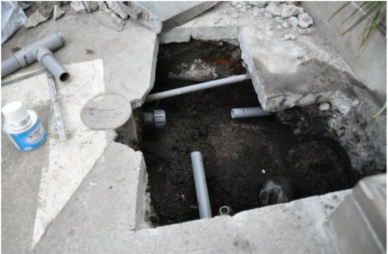
接続方法は決まった、図面通りパイプを切断。しかし問題発生、20年以上経って居るので水道メーターの前にある元栓を閉めても完全に止水出来ない、元栓が錆びているのだ、カー杯ねじっても水が滴り落ちる、仕方なく大型のモンキースパナで元栓の継ぎ手部分を外す。
