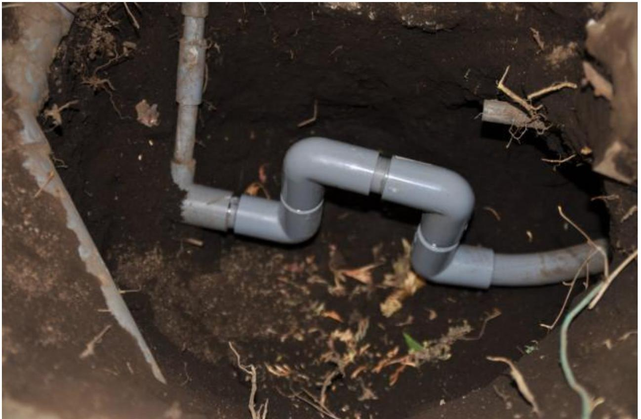
西側の此処から先には漏水が無い事が判明したので元のように接続した、此処で苦労したのがパイプ同士の柔軟がな
